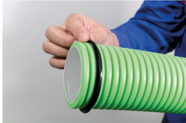
2) Do 2. nebo 3. drážky nasadíme těsnicí kroužek.
